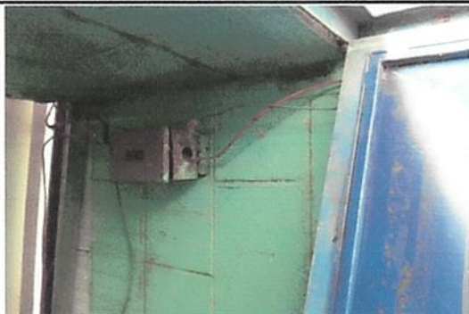
Foto 13: Sustrucción de flípones
