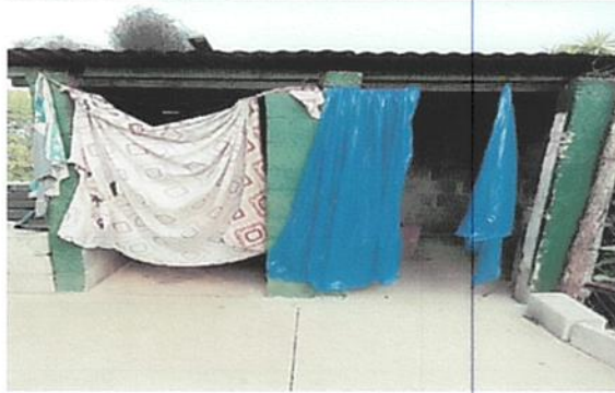
Foto 2: Sustitución de puertas
