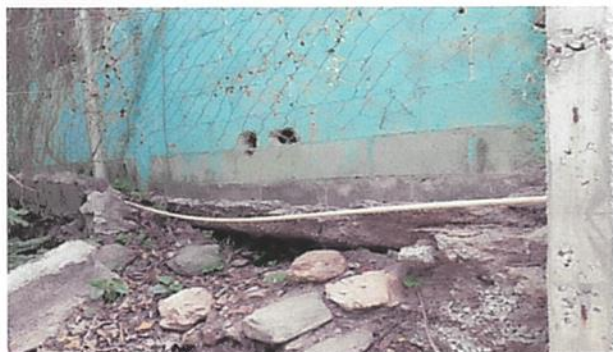
Foto 19: Reparación de muro de contención con aplicación de concreto vertical 25 cm x 20
