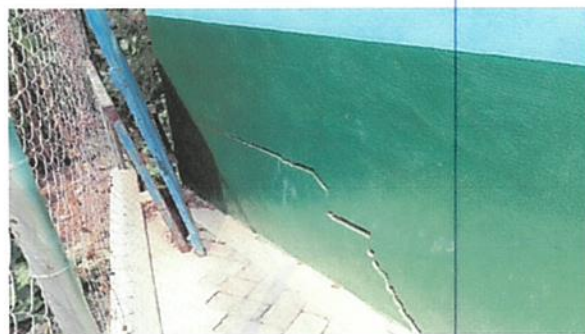
Foto 18: Aplicación de sablita de muros de contención
