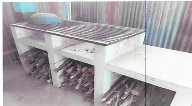
Foto 20: Sustitución de estufa rural completa, incluyendo chimenea y plancha de metal
