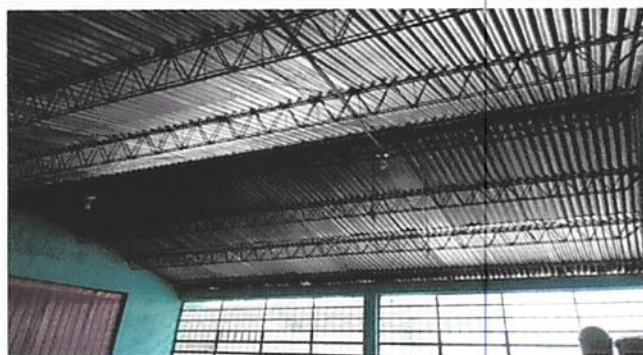
Foto 10: Sustitución de focos
