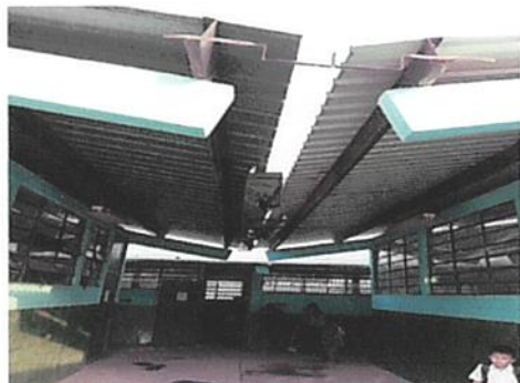
Foto 7: Sustitución de canal de metal
