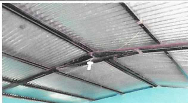
Foto 11: Sustitución de plafonera
