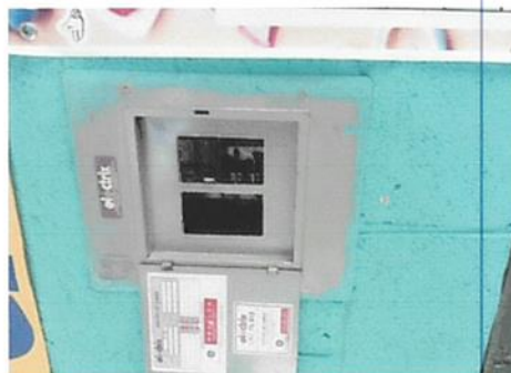
Foto 14: Sustrucción de tableros de flípones
