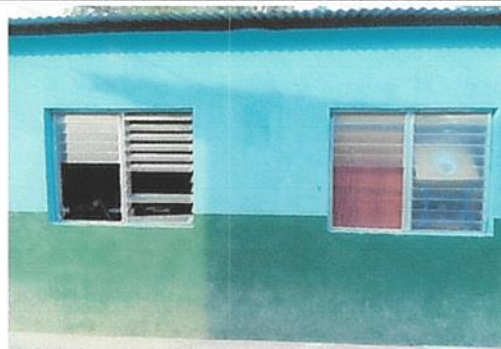
Foto 5: Sustitución de balcones de metal
