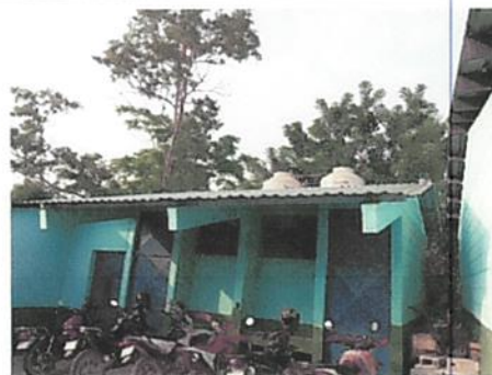
Foto 16: Sustrucción de accesorios de depósitos de agua
