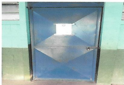
Foto1: Sustitución de chapa
