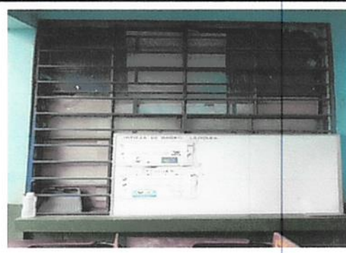
Foto 4: Sustitución de vidrios
