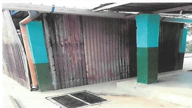
Foto 21: Sustitución de lamina por block en area de cocina
